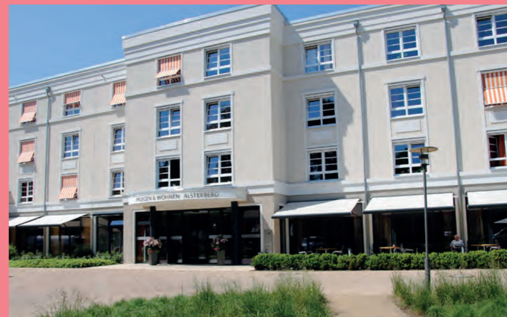
Der Neubau von PFLEGEN & WOHNEN ALSTERBERG führt exemplarisch Merkmale des Bauprogrammes vor. Zum Beispiel die zeitgemäße Fassadengestaltung mit an verschiedenen Standorten wiederkehrenden Elementen, das großzügige und einheitliche Fensterlayout oder die einladenden Foyerzugänge.
